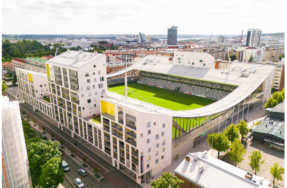
Tammelan Stadion. Tammelaan valmistui jalkapallostadion, jossa on 8000 katsomopaikkaa. Erikoisuutena on yli sata metriä pitkä ripustettu katto, jollaisia ei ole aiemmin Suomessa toteutettu. Kuva: Roope Jakonen
