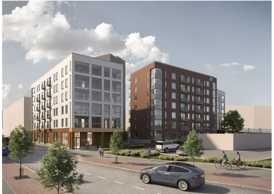
Kuvassa POASIN vuonna 2025 valmistuva uudiskohde Tieteenkatu 4. Kuva: POAS
